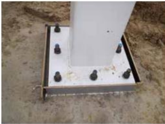
Anclaje de pilar
